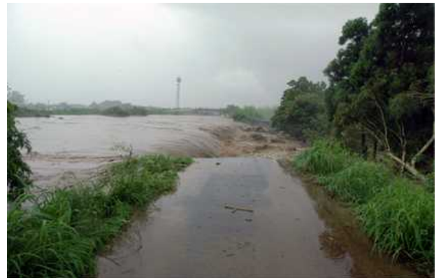
(堤防が決壊した沖端川)
